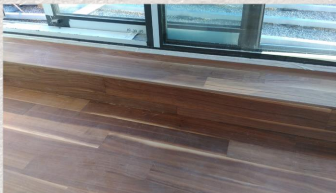
H43 LHD 190 Walnuss Reichraming / Lüftungsstufe
